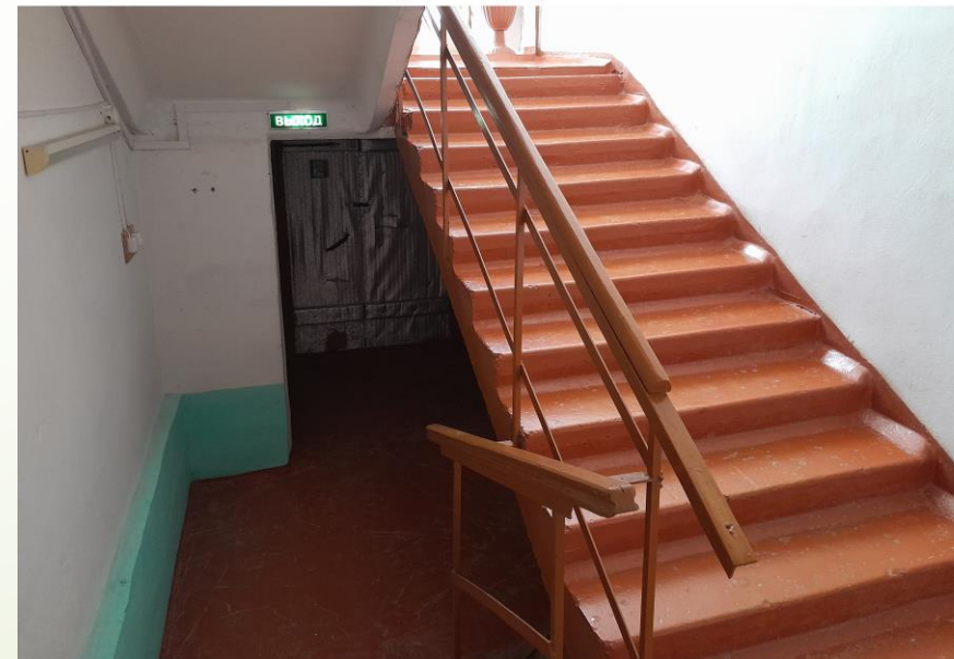
Лестничный пролет. ДО ремонта
